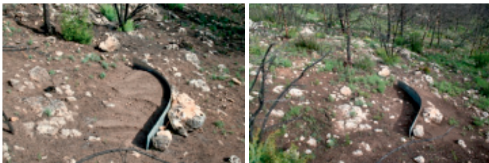
Figura 27. Vista de dos FIS-Fast Installation Silt fences instaladas en mayo de 2008 en el incendio de Navalón, Valencia. La imagen de la derecha fue tomada después del evento del 12 de julio de 2008 y la derecha un año después tras haberse evacuado los sedimentos del evento anterior. Estos instrumentos son de gran utilidad en la inmediatez del postincendio.
