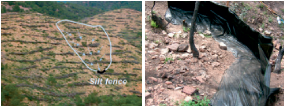
Figura 1. Esquema de la ubicación de una silt fence y de su área de drenaje a la izquierda. Y detalle de una silt fence instalado en una zona quemada del Parque Natural de Serra Calderona, Valencia, a la derecha.
