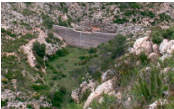
Figura 5. Dique de regulación hídrica en la rambla Salto del Agua, en Millares, Valencia. La cuenca se quemó por completo en 1994. Se observa la zona de sedimentación aguas arriba del dique.
