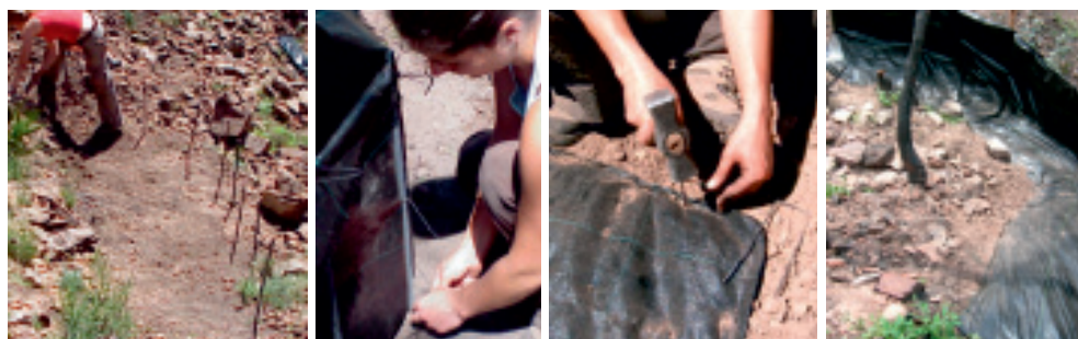
Figura 2. Ilustración del procedimiento de instalación de mallas de retención de sedimentos ( silt fences ). De izquierda a derecha: Preparación de la estructura de sostén con barras de hierro corrugado clavadas en el suelo. Fijación del geotextil a las barras con bridas plásticas. Fijación del geotextil al suelo mediante grapas de acero. Silt fence completo.
